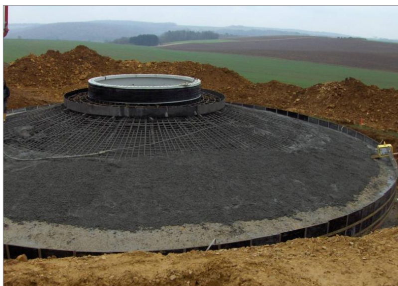
Figure 3 : Exemple de ferrailage en radier pour une éolienne (chantier en cours)
